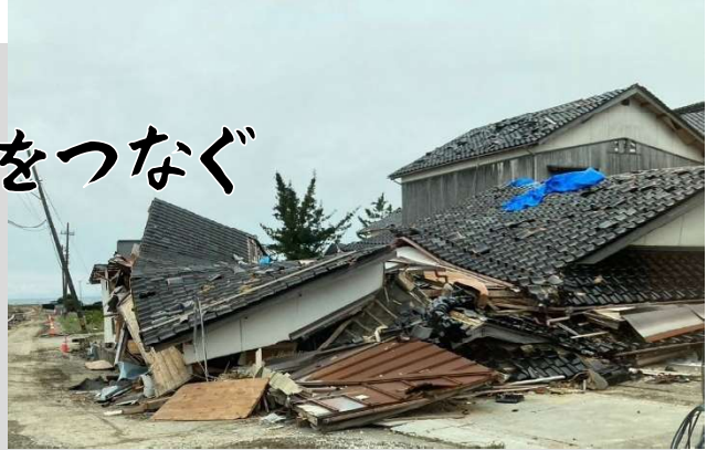
令和6年能登半島地震での被災地の様子（社協被災地支援ボランティア活動の記録写真より引用）
